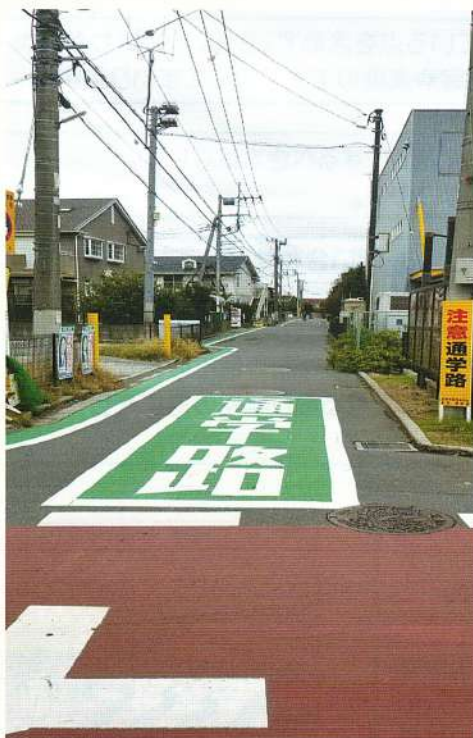
《整備されたグリーンカラー舗装》
